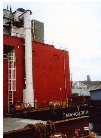
Instalación en una central eléctrica flotante en Nicaragua Installation in the floating power plant in Nicaragua
