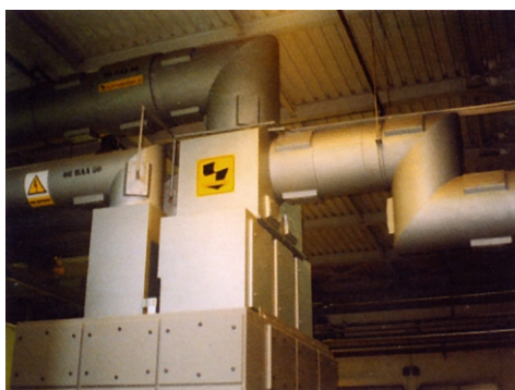
Conexión al interruptor de un generador Connection to generator circuit breaker
