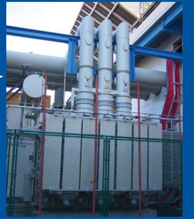
Przyłącze do transformatora blokowego Connection to step-up transformer
